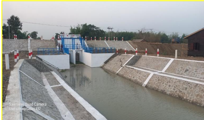
ထန်းတပင်မြို့နယ်၊ တပွန်ရေတံခါး ၆' x ၈' (၂)ပေါက်
