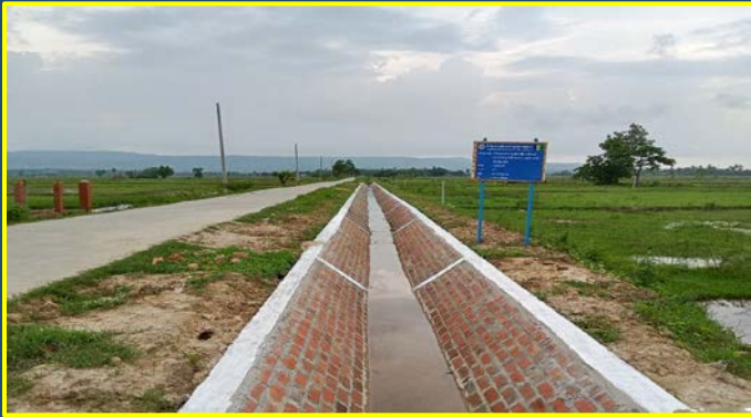
မင်းရဲရေလှောင်တံခံ ၊ တူးမြောင်းမကြီး ပေတိုင်အမှတ် (၁၀+၀၀၀)ပေ မှ (၁၁+၂၅၀)ပေအတွင်း လိုင်နှင့်ပြုပြင်ခြင်း
