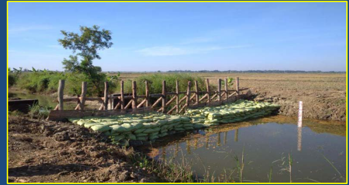
ပေါင်းတည်မြို့နယ် ကိုယ်ဝန်ဆောင်ကျေးရွာအနီး ကမ္မရိုးပေါ်တွင် ယာယီချောင်းပိတ်တံ ပြုလုပ်ခြင်းလုပ်ငန်း (ပိတ်ချက်- ၃)
