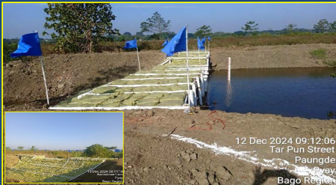
ပေါင်းတည်မြို့နယ် မကျီးပင်ကျေးရွာအုပ်စု ဦးဂျစ်တေးရေတံခါးအနီး ချောင်းပေါက်အား ယာယီချောင်းပိတ်တံပြုလုပ်ခြင်း
