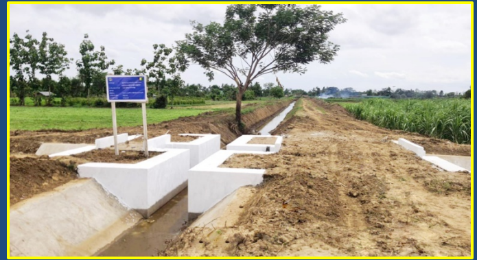
မြောက်နင်းရေသောက်စနစ် CL-8-B နှင့် CL-8-B1 တူးမြောင်းများ တူးမြောင်းပုံစံကျ ပြန်လည်ပြုပြင်ခြင်း
